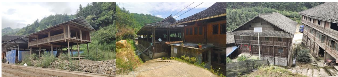
图 16 程阳八寨木构建筑
