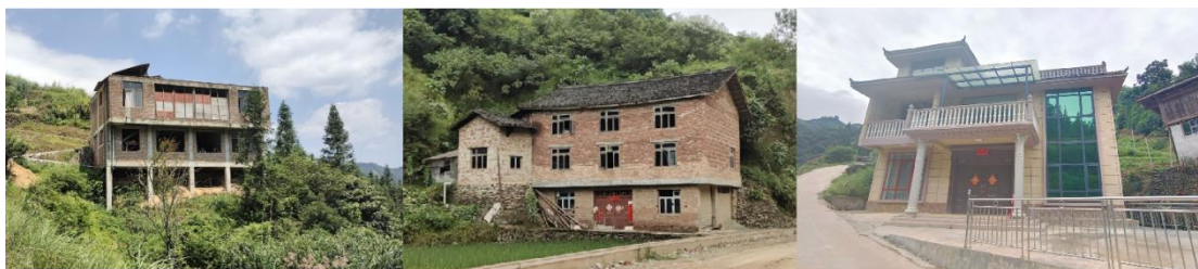
图 17 程阳八寨砖混建筑
